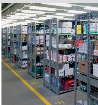
Monitorización de las condiciones ambiente en almacenes
